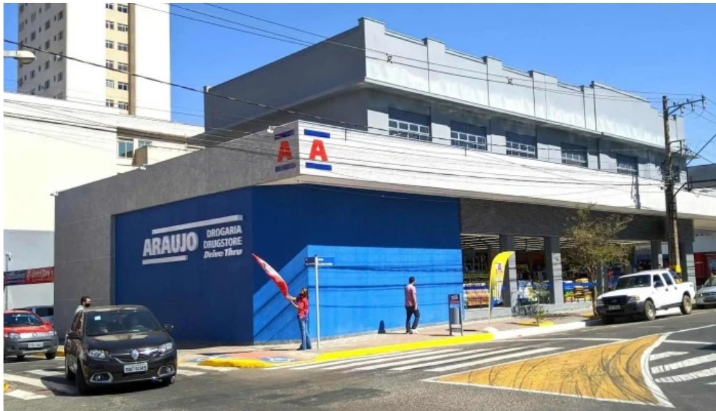
Drogaria araujo alfenas horario
