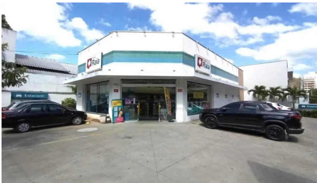
Droga raia tres rios
